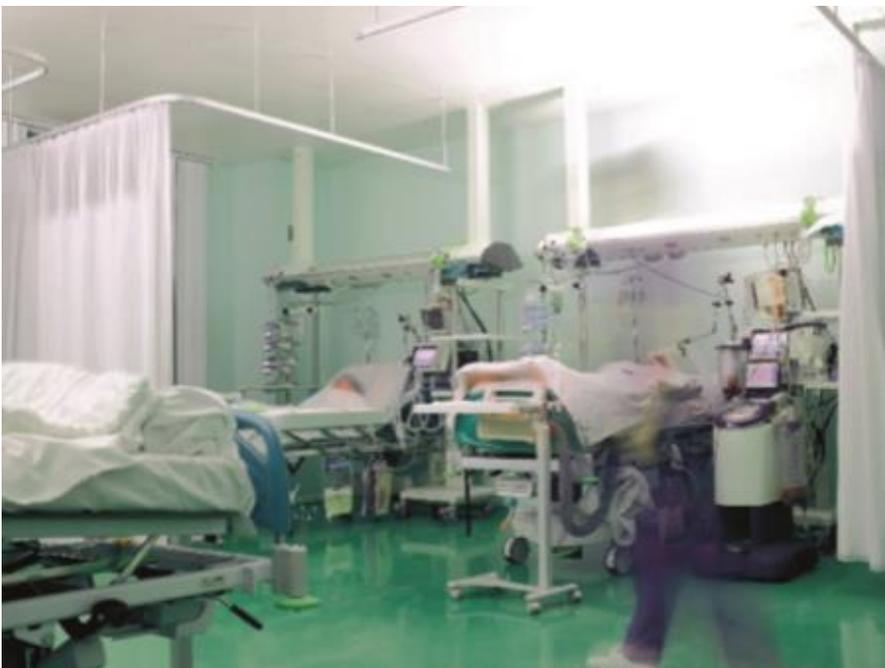
Keine störenden Zugscheinungen im Bettenbereich Absaugung der erwärmten Luft oberhalb der medizintechnischen Geräte.
