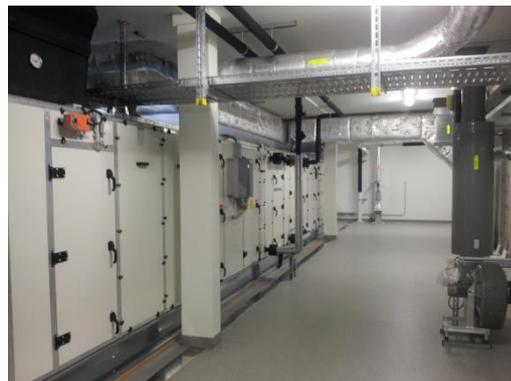
Abb. 7: Technikzentrale mit energetisch hoch-effizienter Lüftungsanlage
