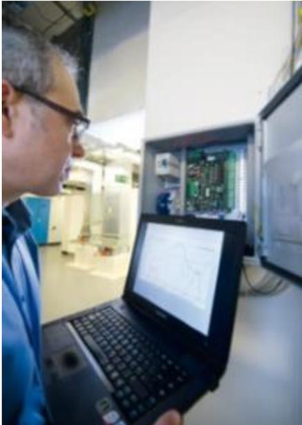
Durch ein spezielles Energie-Monitoring können zeitlich eng aufgelöste Mess- und Verbrauchsdaten von Raumluft-technischen Anlagen (RLT-Anlagen) erfasst werden. Die damit erkennbaren Optimierungspotentiale insbesondere im Bereich der Regelungstechnik können zu hohen Energie- und Kosteneinsparungen führen, ohne GMP-Anforderungen zu verletzen. Der Erfolg der umgesetzten Maßnahmen lässt sich quantitativ und witterungsbereinigt nachweisen.
